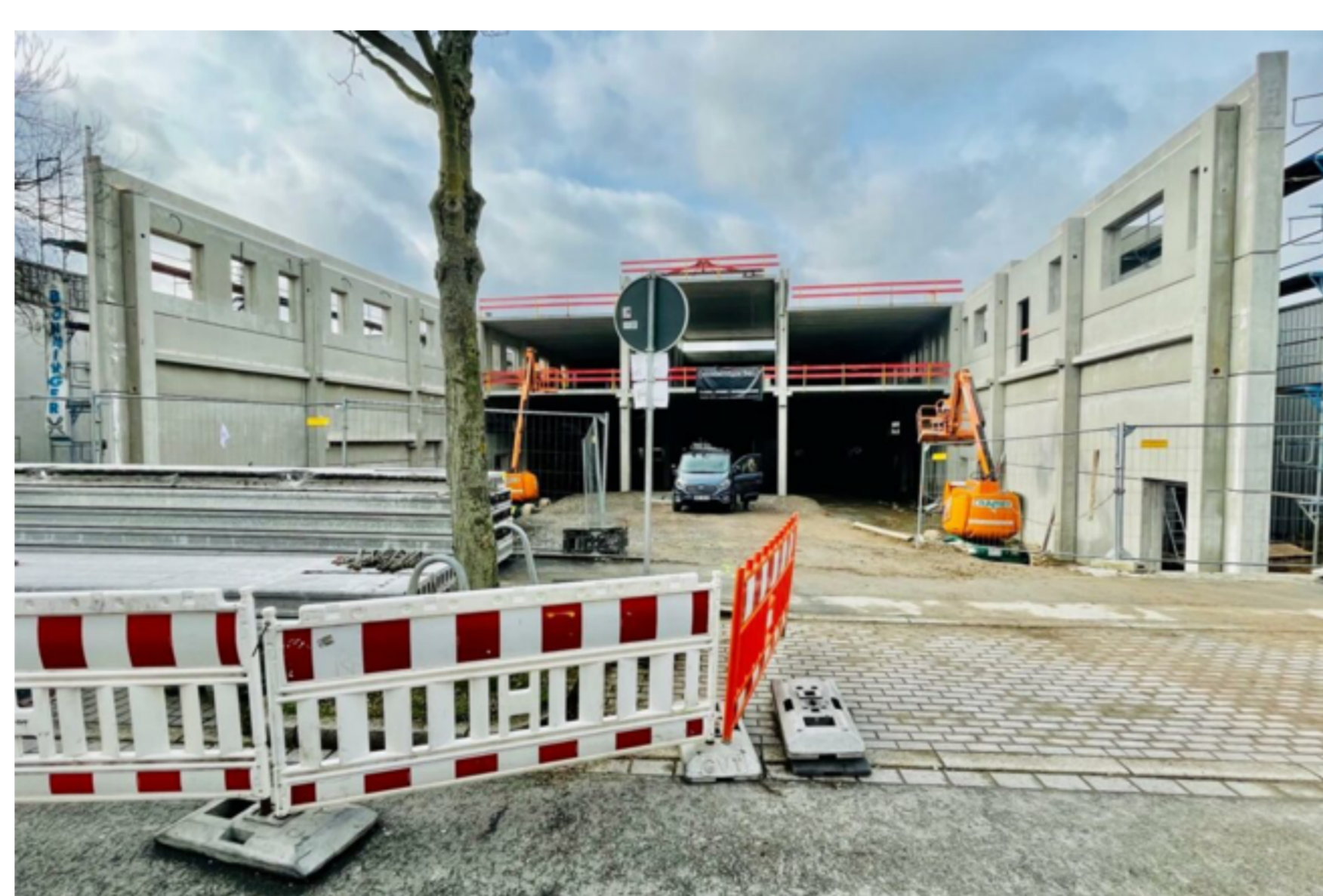
Blick von der Schleefstraße auf den neuen Anbau: Noch fehlt ein Teil des Daches. © Jörg Bauerfeld
